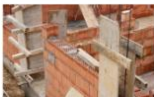
砌体结构、砖混结构应先砌墙后浇柱 (✓)
