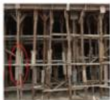
立杆接长采用对接夹板接头 (✓)
