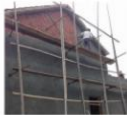
单排支撑、无剪刀撑 (✗)
