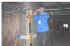
电缆线架空保护 (✓)
