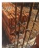
墙体设置拉结筋 (✓)
