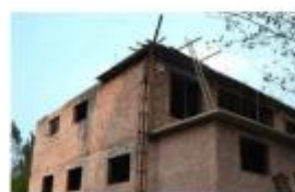
未设置圈梁、构造柱 (✗)
