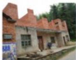
在现有建筑上随意加盖（×） 利用房屋墙体擅自搭设（×）
