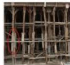
立杆接长采用对接夹板接头(✓)
