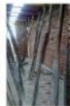
立杆接长未采用对接夹板接头(✗)
