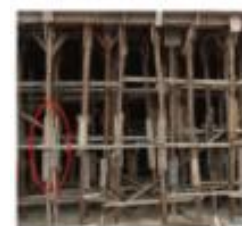
立杆接长采用对接夹板接头(✓)
