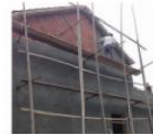
单排支撑、无剪刀撑(✗)
