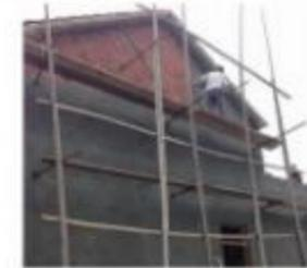
单排支撑、无剪刀撑(✗)
