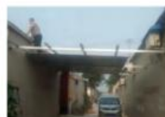
利用房屋墙体擅自搭设 (✗)
