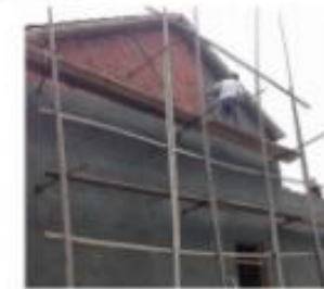
单排支撑、无剪刀撑(✗)
