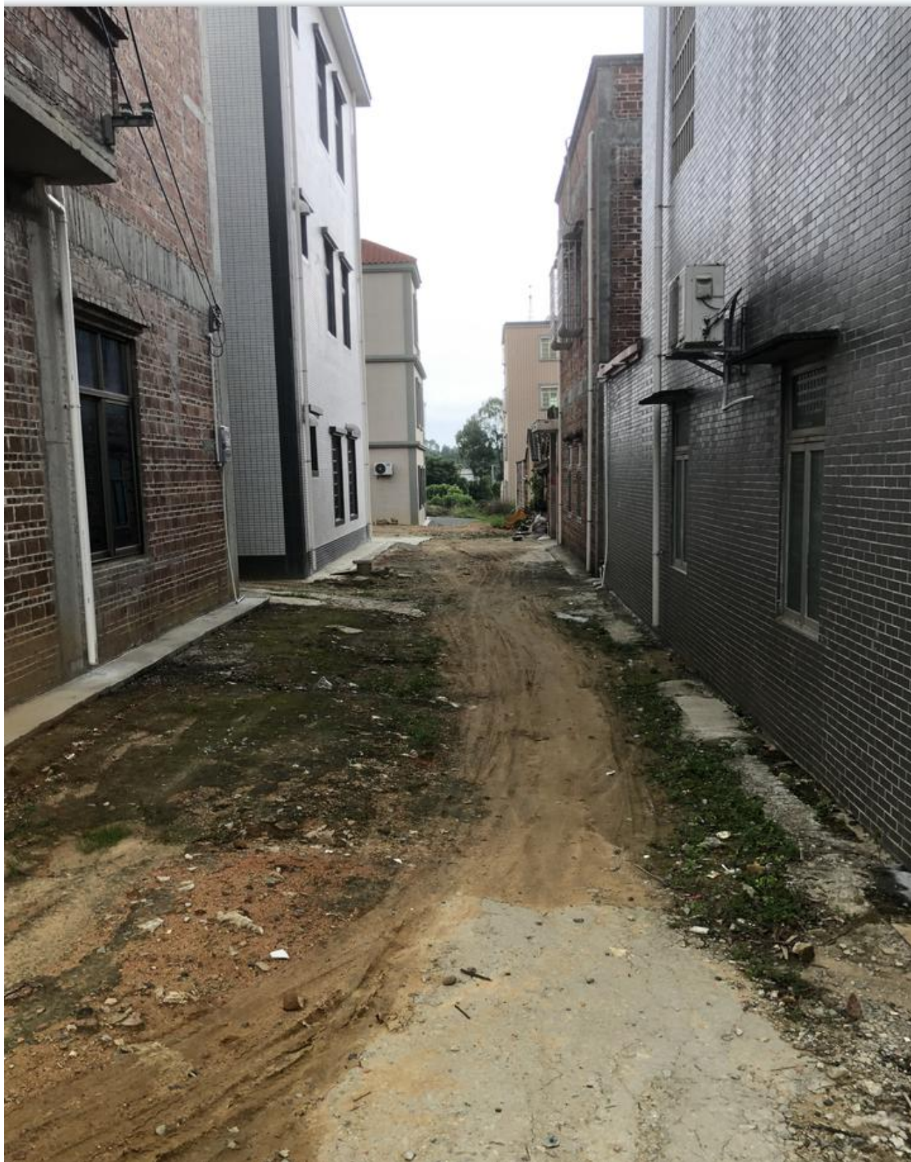
村内巷道与建筑改造前照片
