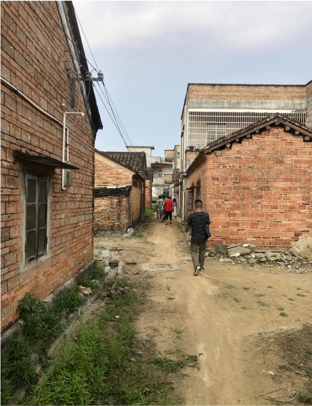
村内巷道与建筑改造前照片
