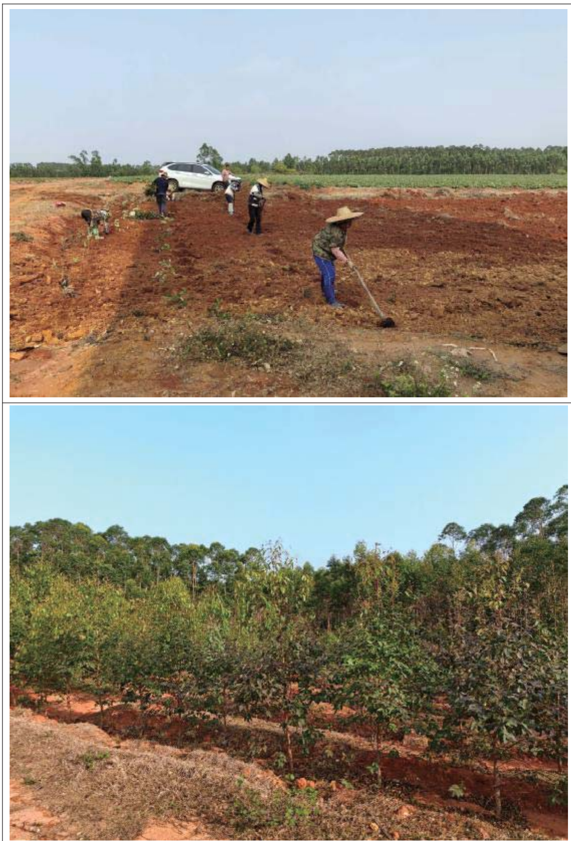
图 3-5 临时用地生物和化学工程现场照片
