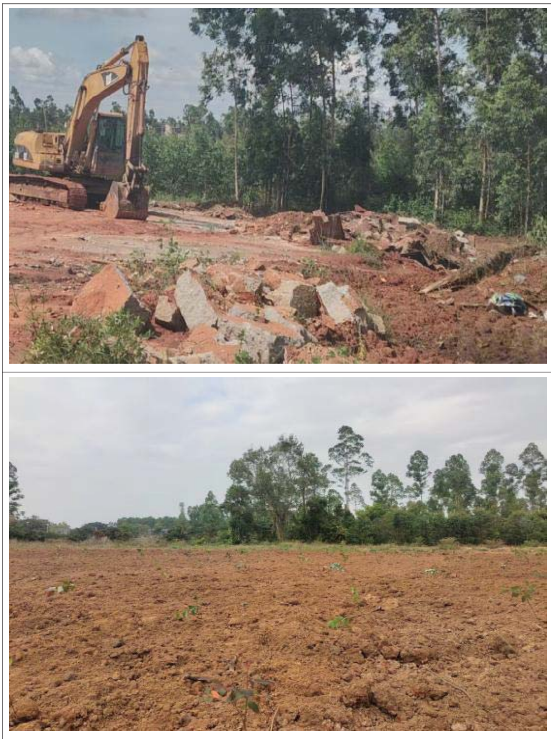
图 2-1 临时用地清理工程对比照片
