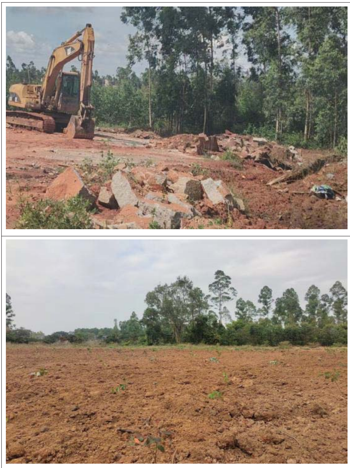
图 3-2 临时用地清理工程对比照片
