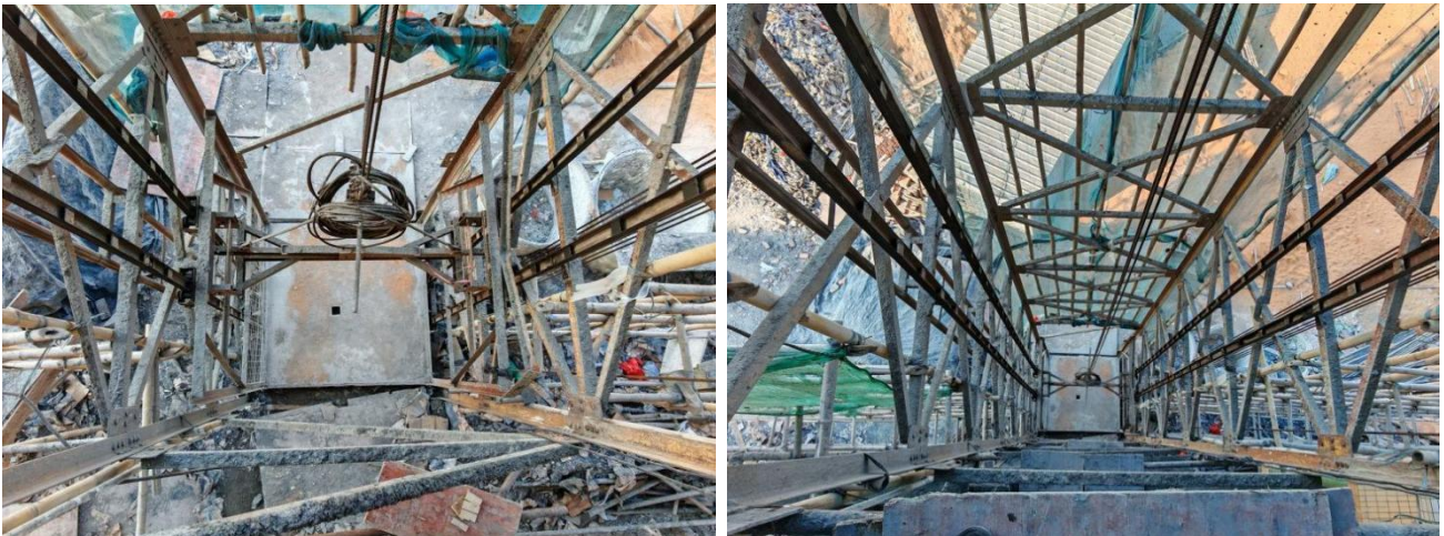
图 5 施工升降机通道俯视地面内部情况
