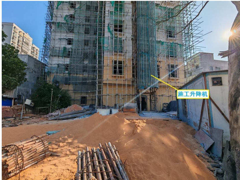
图 4 施工升降机设置在临街背面
