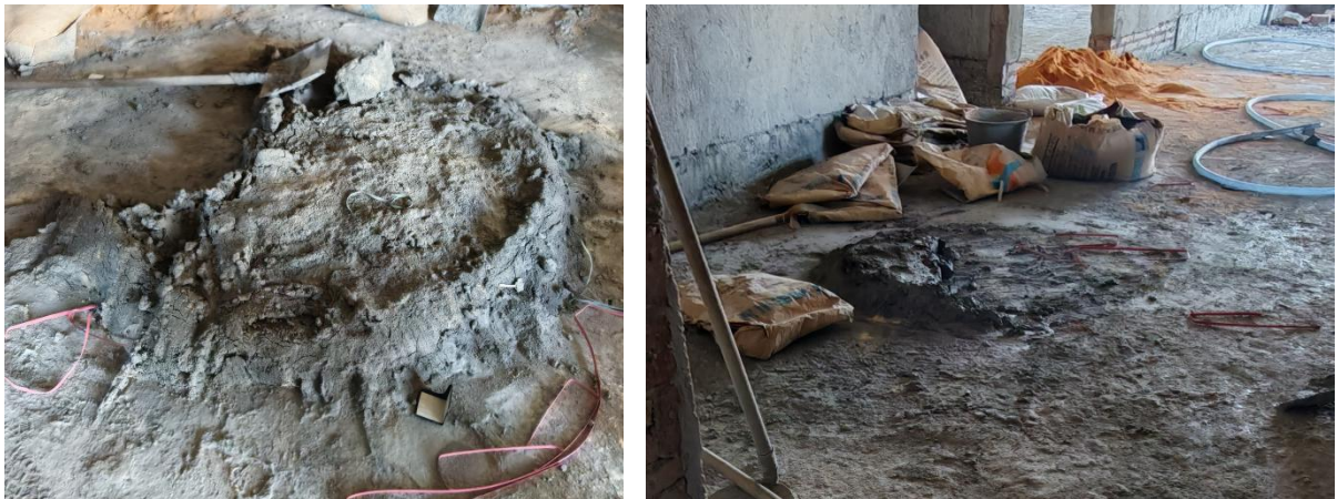
图 10 八楼（左）、九楼（右）水泥拌浆情况
