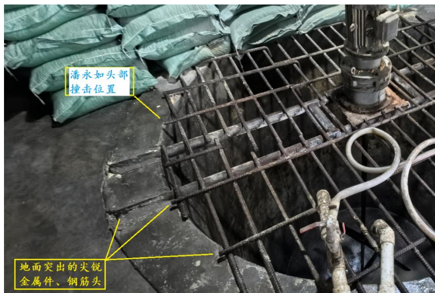
图 7 当事人趴倒位置地面突出的螺纹钢筋头
