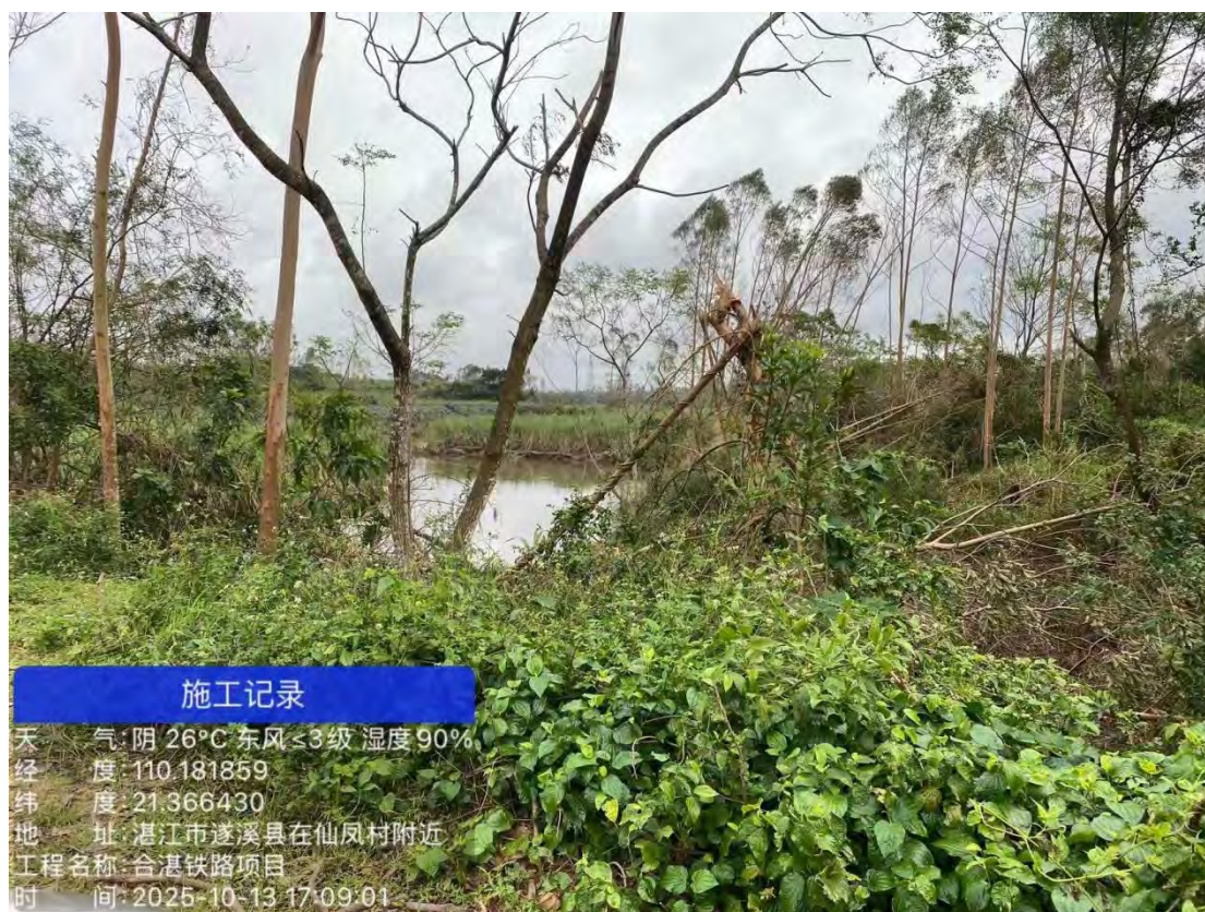
图 11 仙凤村施工便道-2 现场照片
