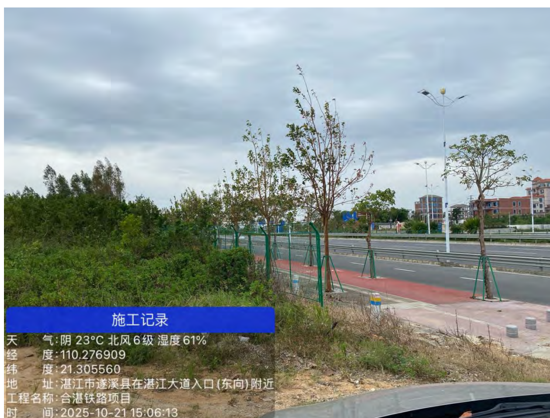
图 24 茅村村施工便道-1 现场照片
