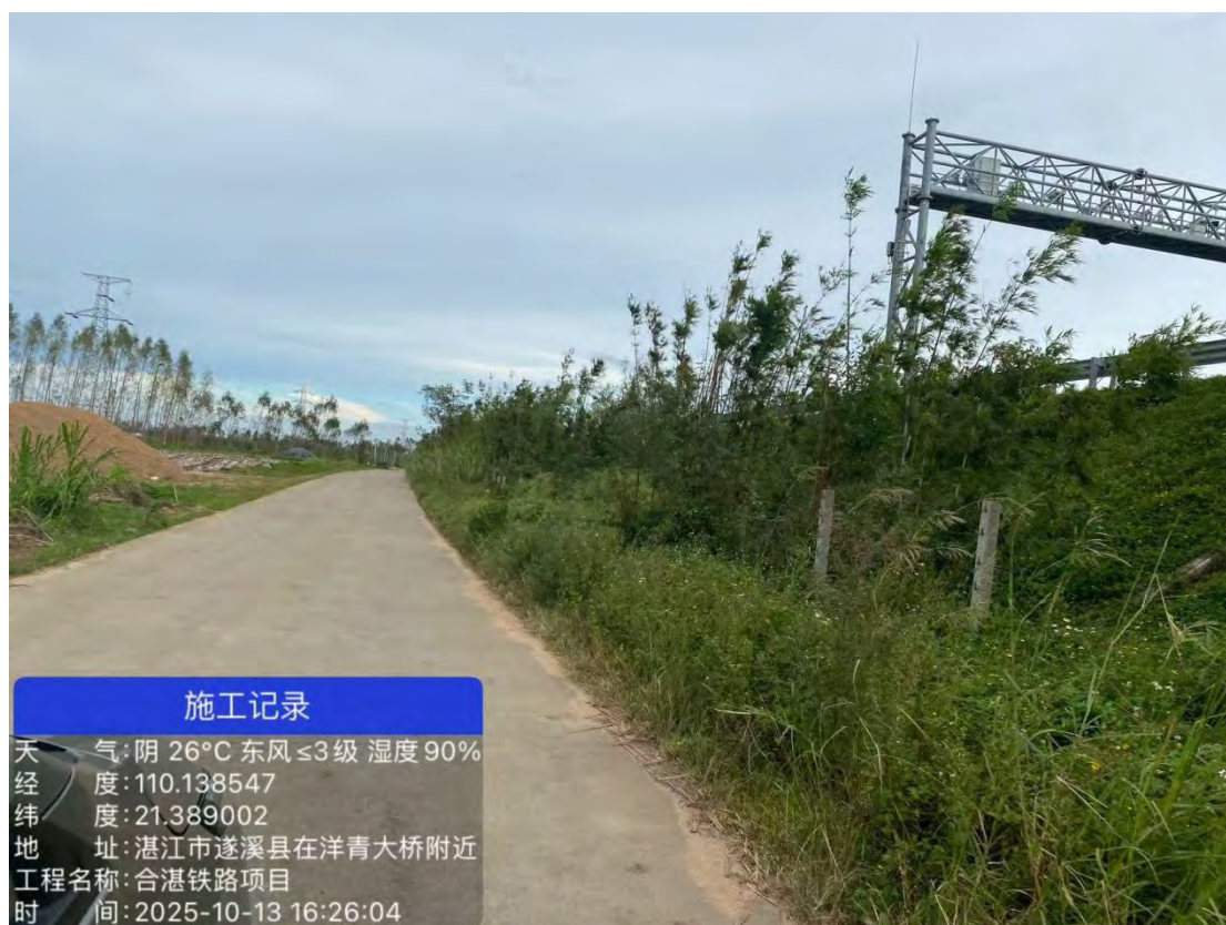
图 5 洋青分场施工便道现场照片
