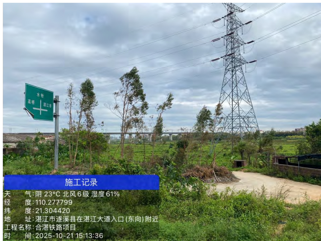
图 25 茅村村材料堆场-3 现场照片
