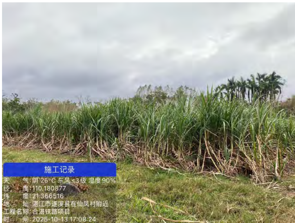
图 9 寮客-仙凤村施工便道现场照片
