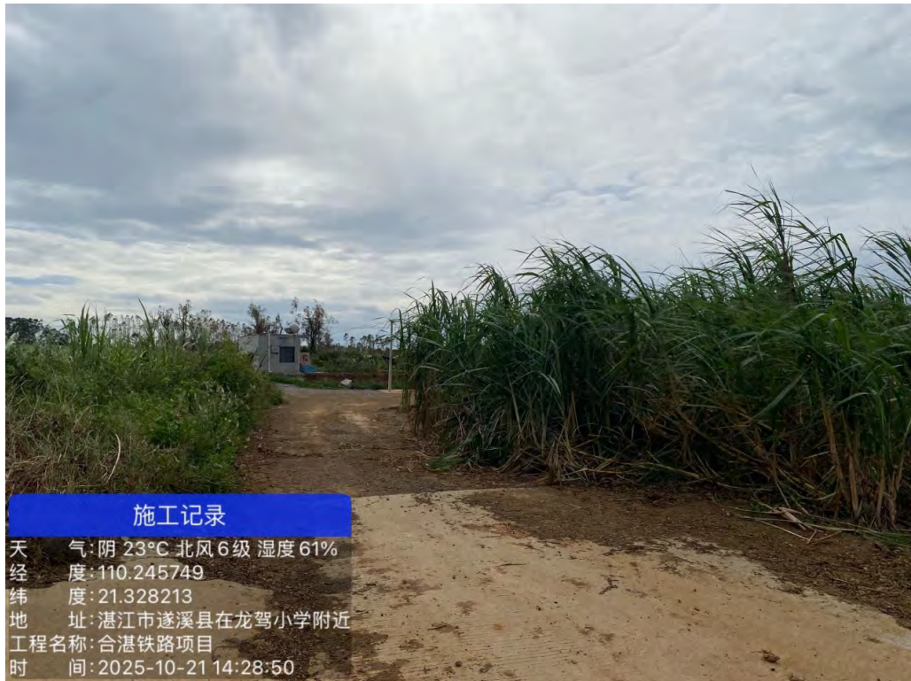
图 27 茅村村施工便道-2 现场照片
