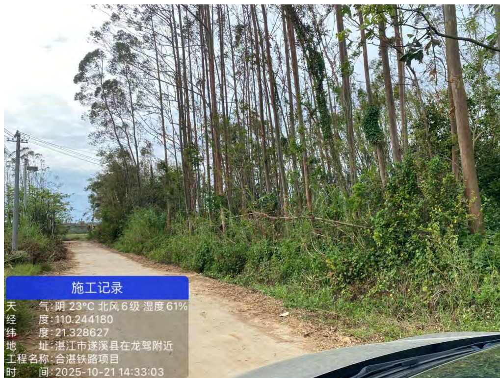
图 21 沙坡-茅村村施工便道现场照片
