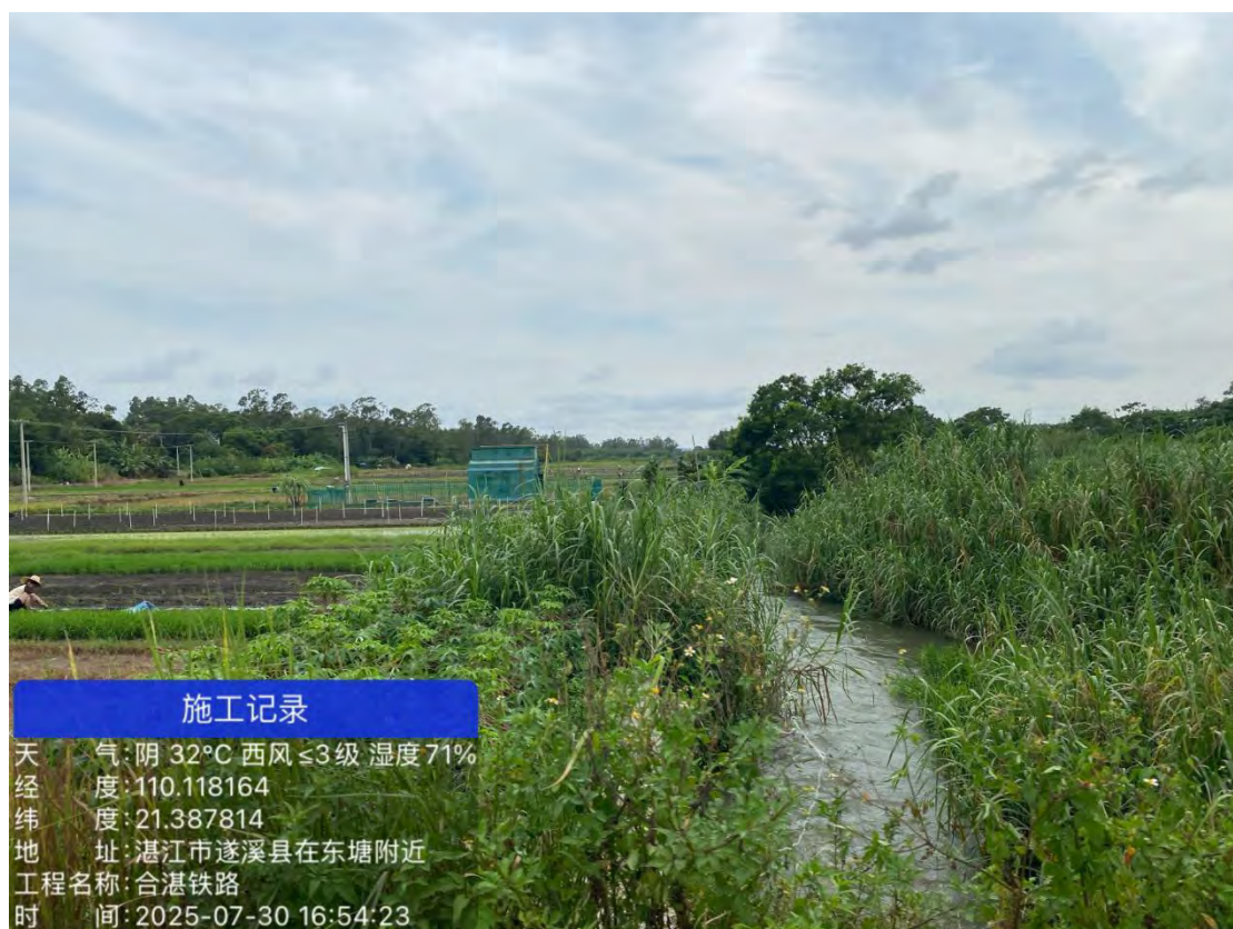
图 1 俩塘村施工便道现场照片
