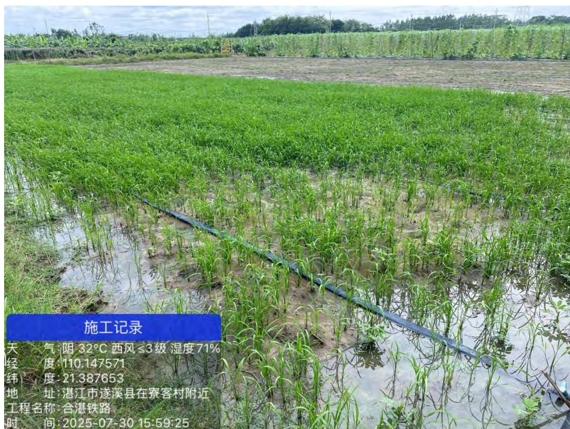
图 7 寮客村材料堆场现场照片
