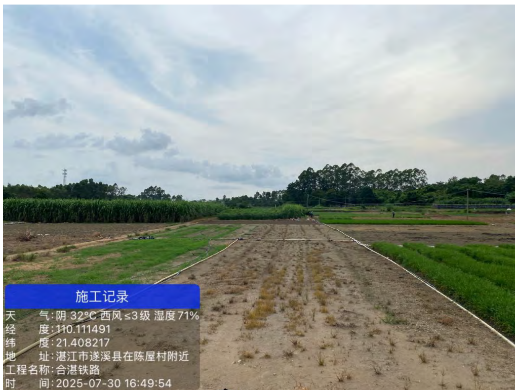
图 3 陈屋-城榄村施工便道现场照片
