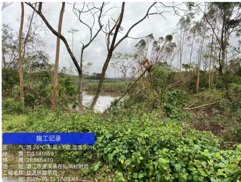
图 11 仙凤村施工便道-2 现场照片
