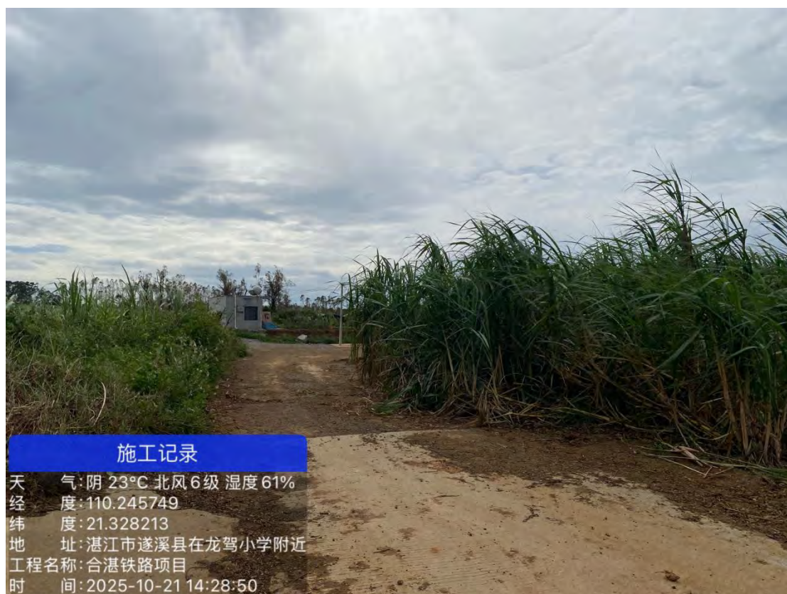
图 27 茅村村施工便道-2 现场照片
