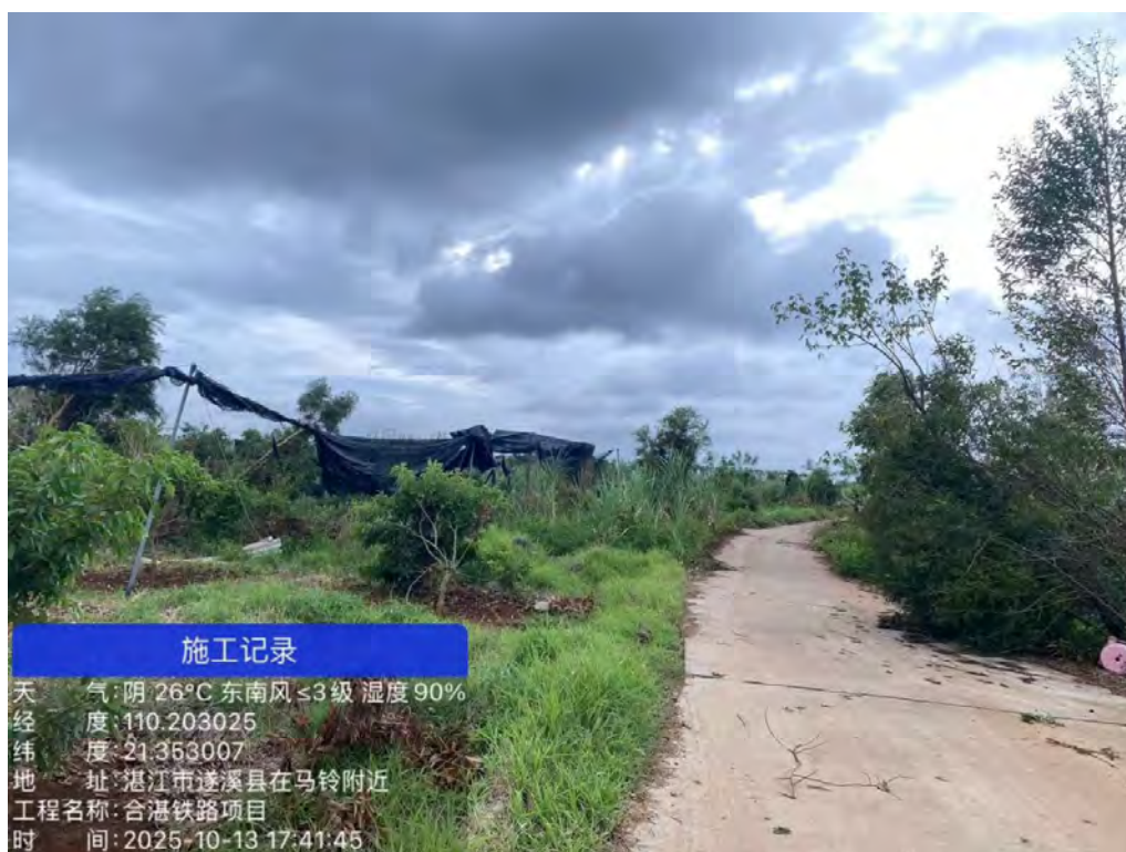
图 12 风朗村施工便道-1 现场照片
