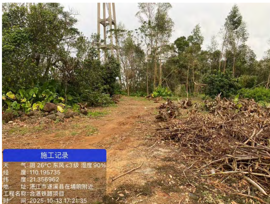
图 13 风朗村施工便道-2 现场照片
