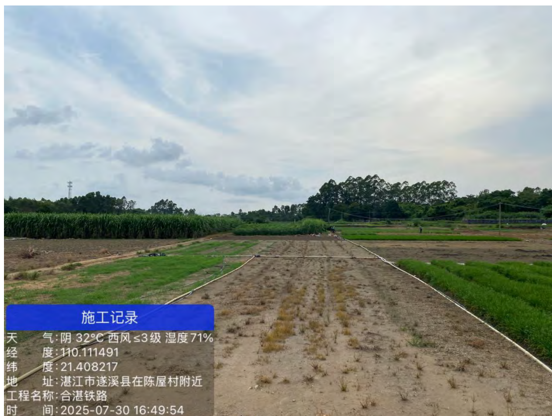
图 3 陈屋-城榄村施工便道现场照片
