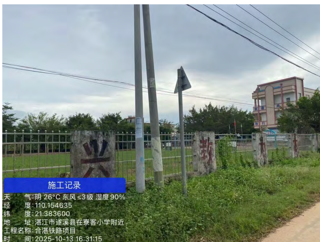
图 8 寮客村施工便道-2 现场照片
