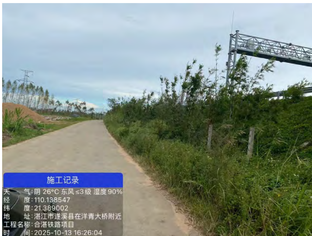
图 5 洋青分场施工便道现场照片
