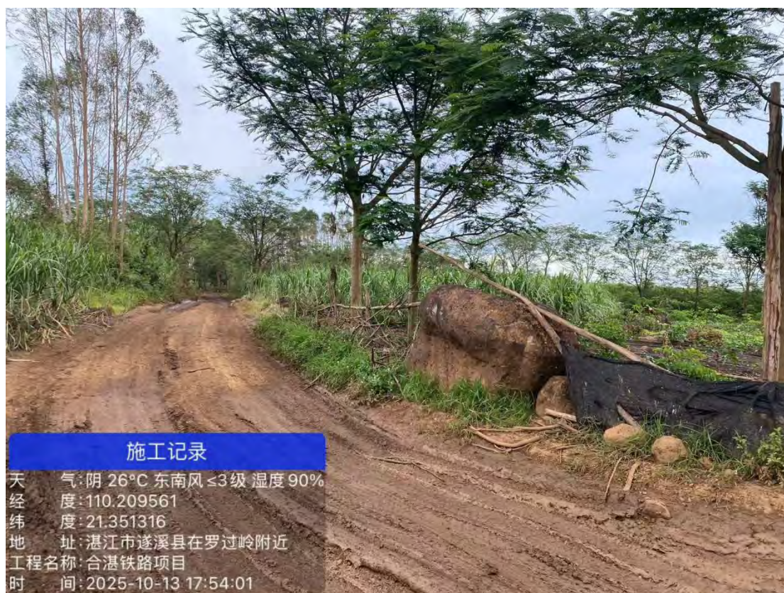
图 15 风朗-沙坭村材料堆场-2 现场照片
