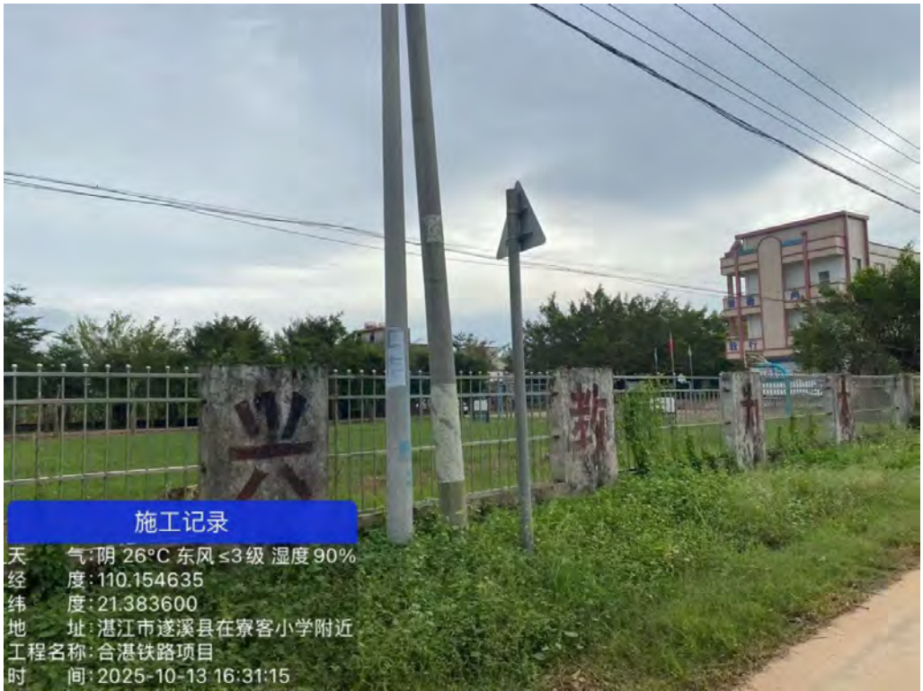
图 8 寮客村施工便道-2 现场照片
