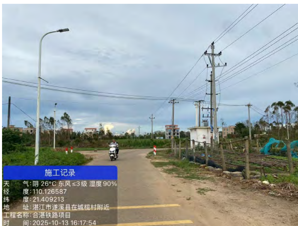
图 4 城榄村施工便道现场照片
