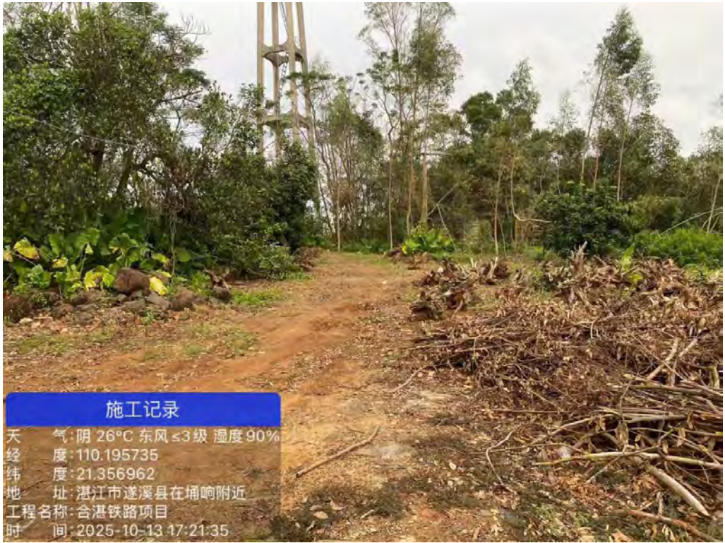
图 13 风朗村施工便道-2 现场照片
