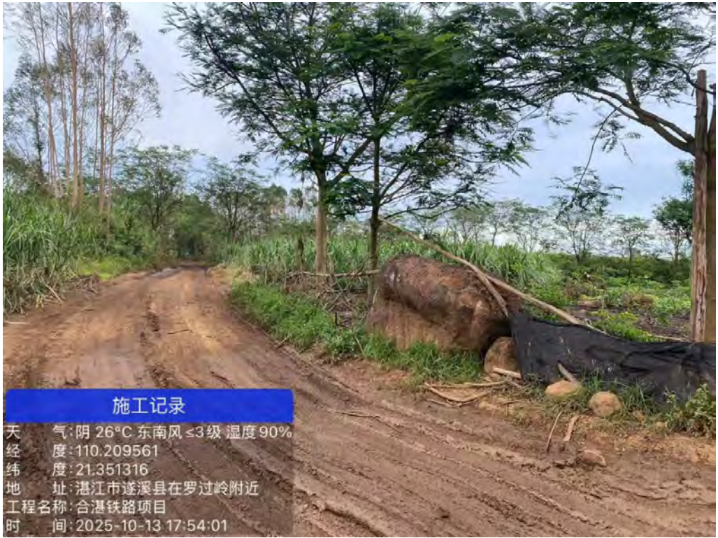
图 15 风朗-沙坭村材料堆场-2 现场照片
