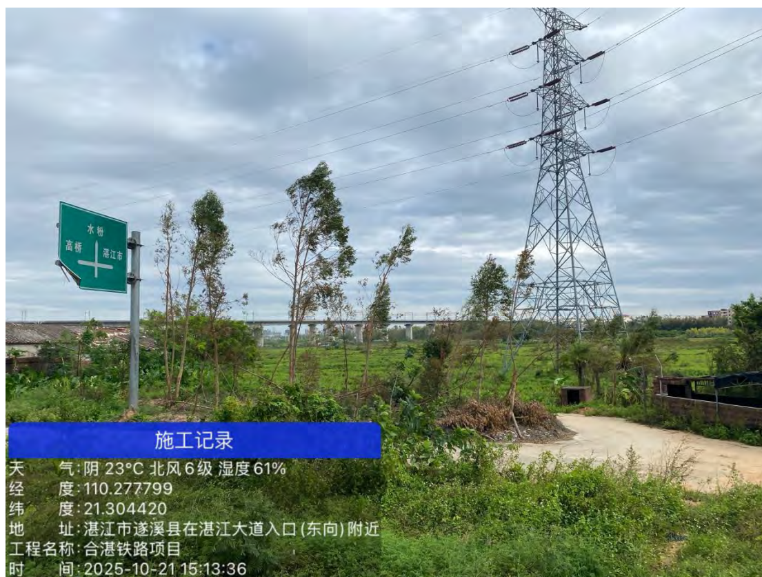
图 25 茅村村材料堆场-3 现场照片
