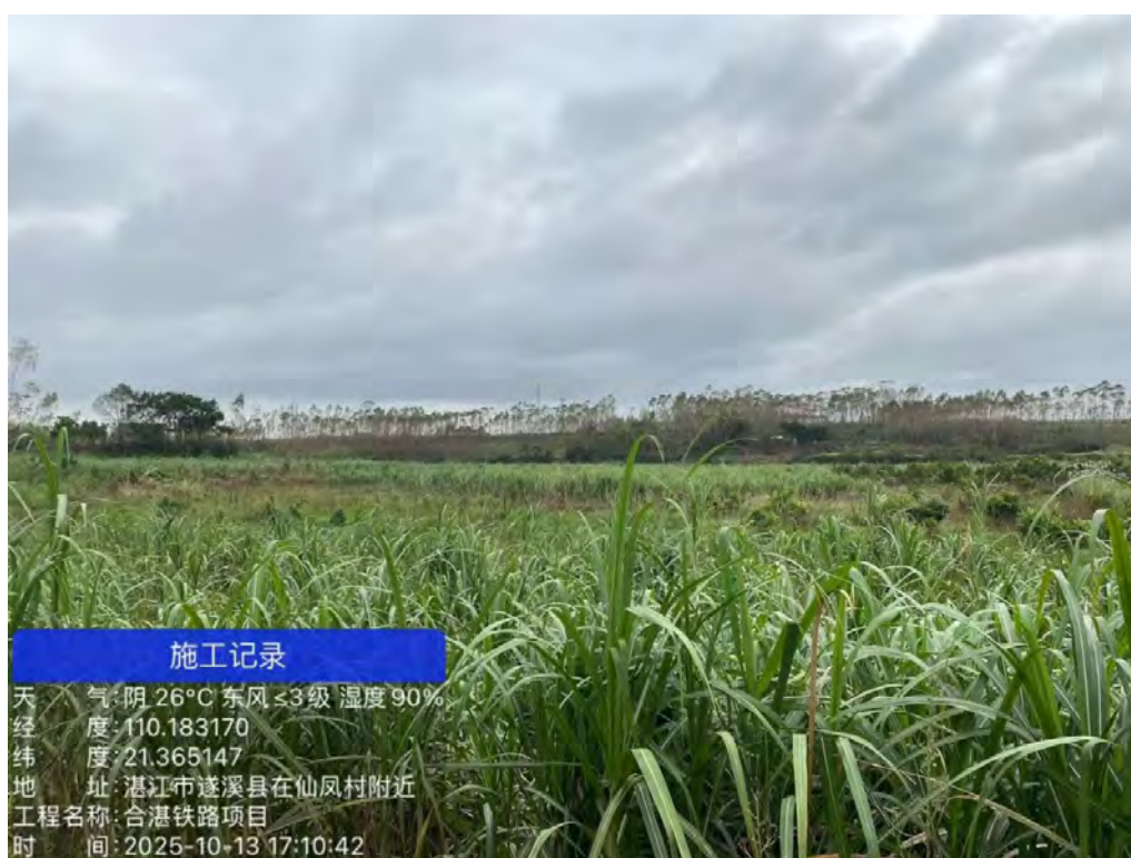
图 10 仙凤村施工便道-1 现场照片
