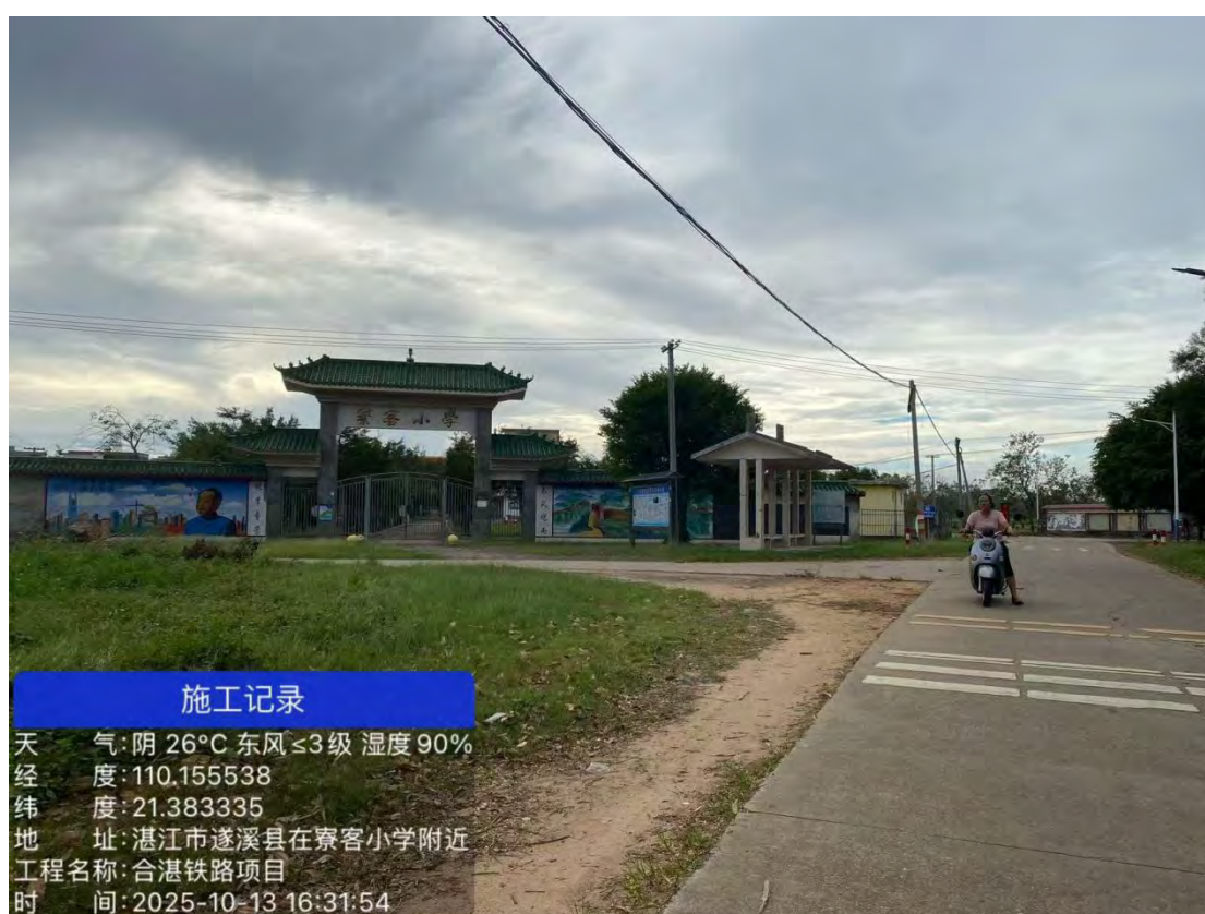
图 6 寮客村施工便道-1 现场照片
