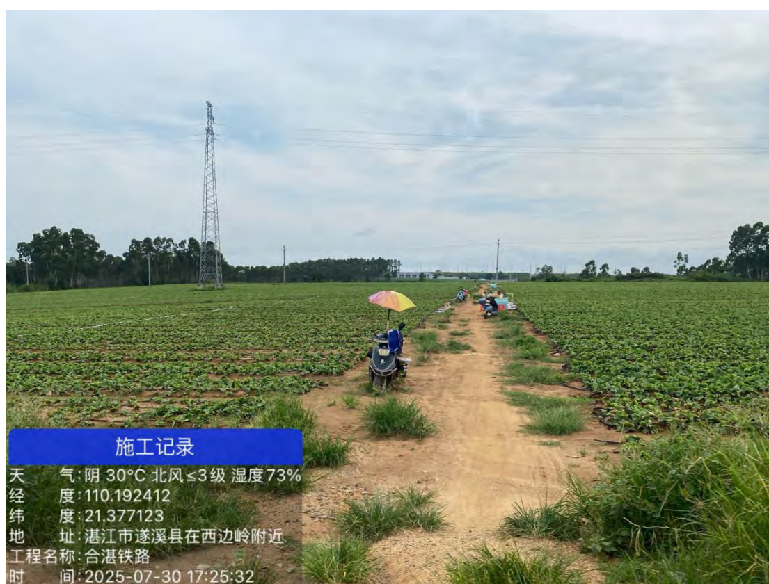
图 26 茅村村材料堆场-4 现场照片
