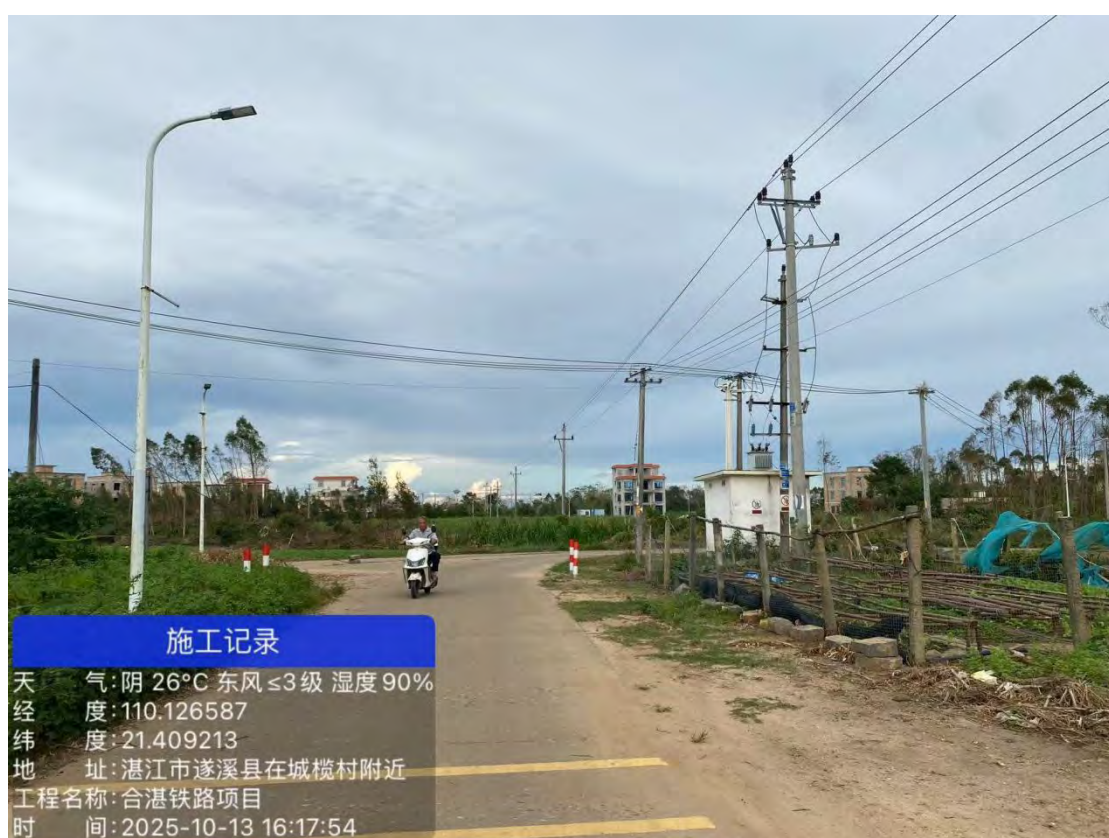
图 4 城榄村施工便道现场照片
