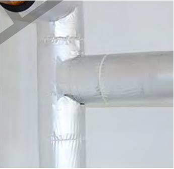
用胶带将裁剪处密封再用扎带扎紧即可完工
