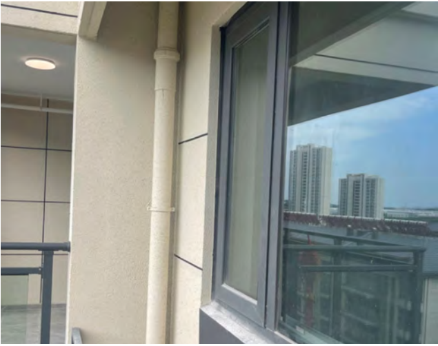
外墙落水管管卡图示
