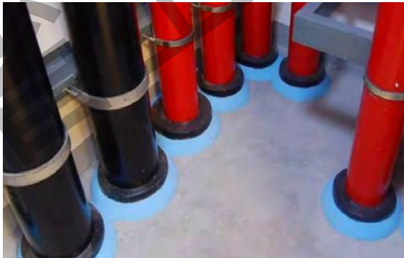
不保温金属管道防火封堵
