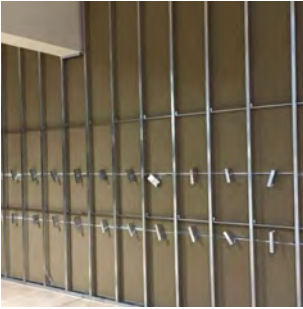
轻钢龙骨隔墙
