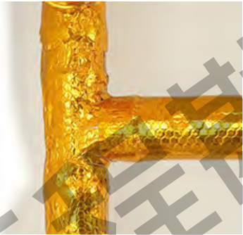
在三通处上下粘贴好阻尼片
