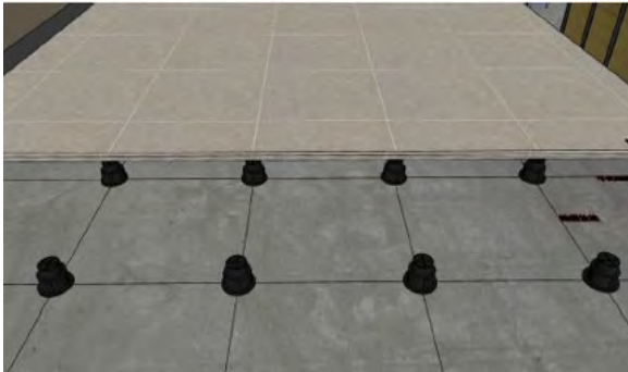
架空地板管线敷设
