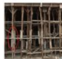
立杆接长采用对接夹板接头(✓)
