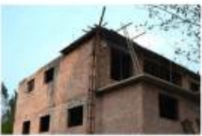
未设置圈梁、构造柱 (✗)
