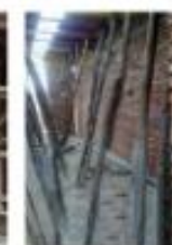
立杆接长未采用对接夹板接头(✗)
