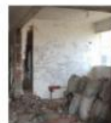
建筑垃圾、废渣集中 堆在楼板上 (✗)
