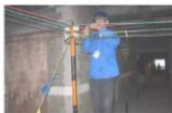
电缆线架空保护 (✓)
