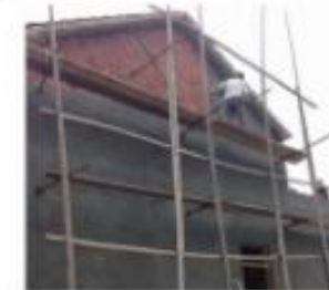
单排支撑、无剪刀撑(✗)
