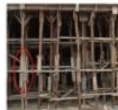
立杆接长采用对接夹板接头(✓)
