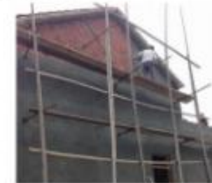
单排支撑、无剪刀撑(✗)
