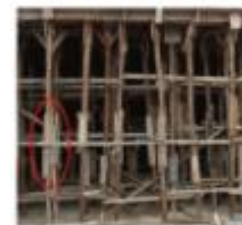
立杆接长采用对接夹板接头(✓)
