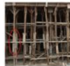
立杆接长采用对接夹板接头(✓)
