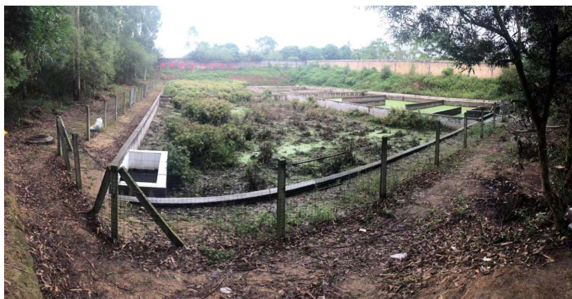
图5-1 调入地块现场照TR01
